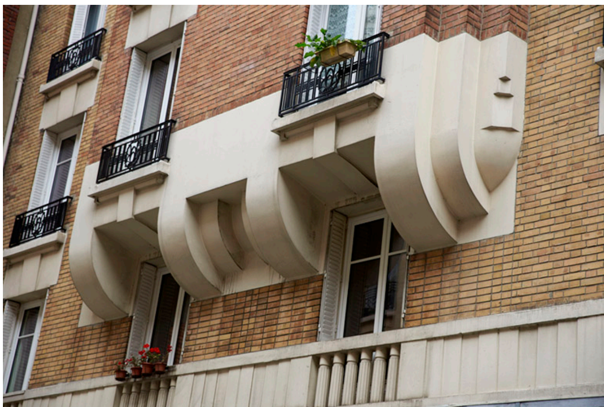
Vue d'un encorbellement de bow window.
