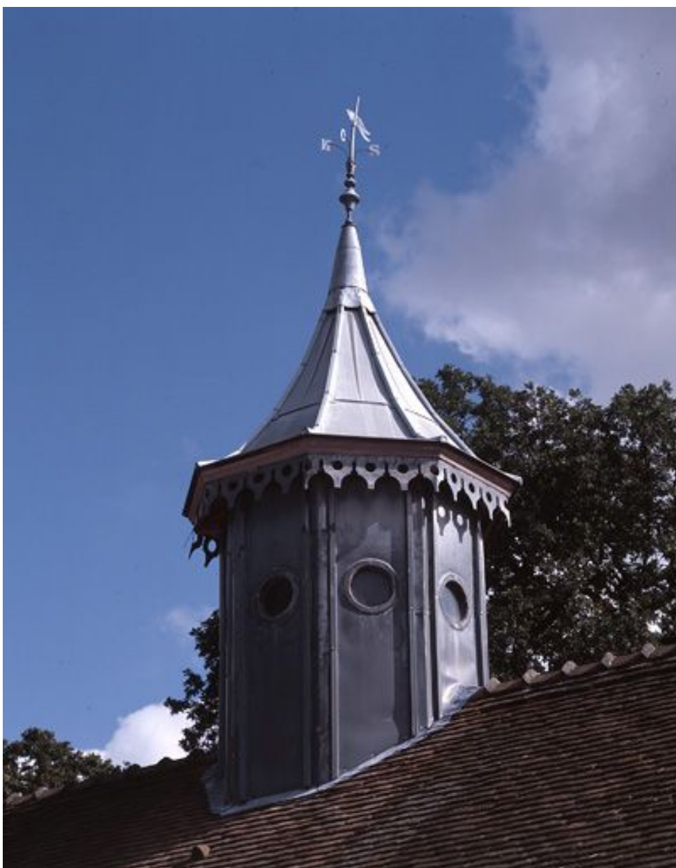
Communs du château : détail du clocheton qui surmonte le toit.
