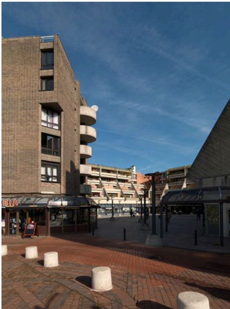
Détail du traitement de l'angle de l'immeuble bordant la Grand'Place.
