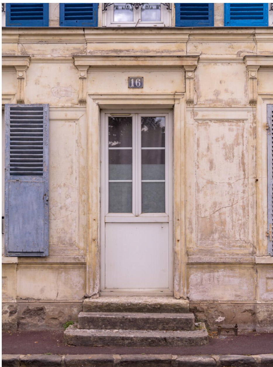
Porte d'entrée de la partie sud.
