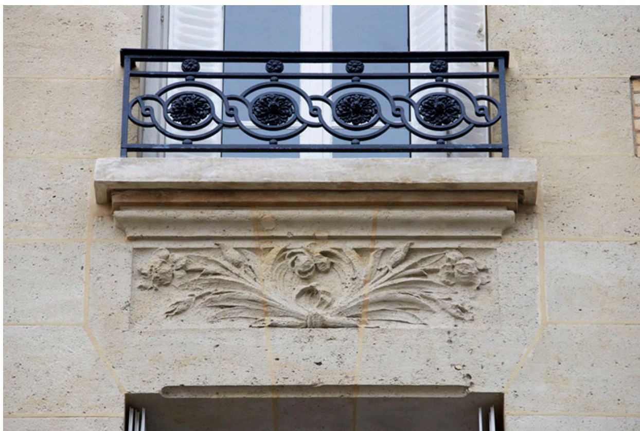
Détail de la ferronnerie et du décor sculpté d'une fenêtre.
