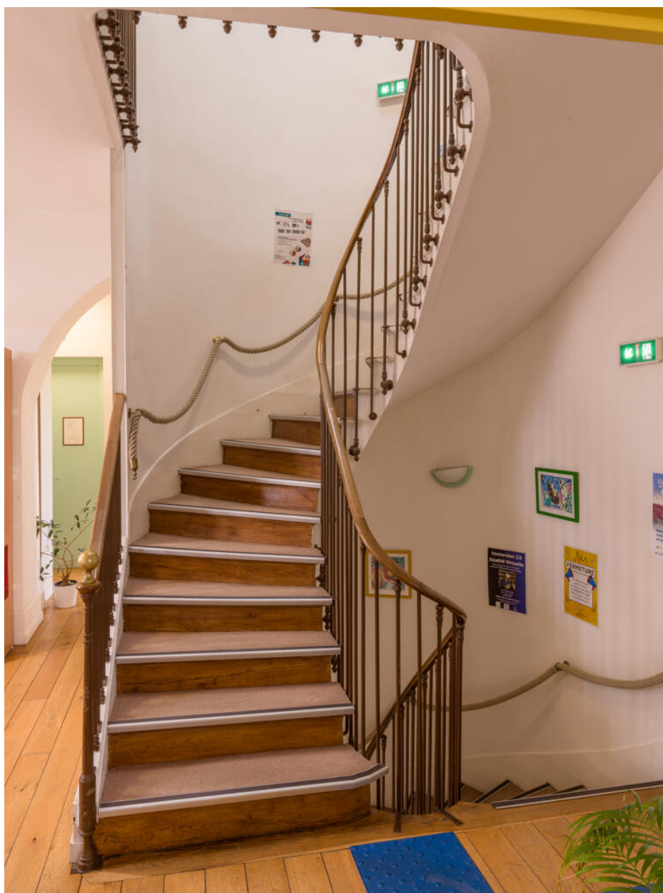
L'escalier au niveau de l'étage.
