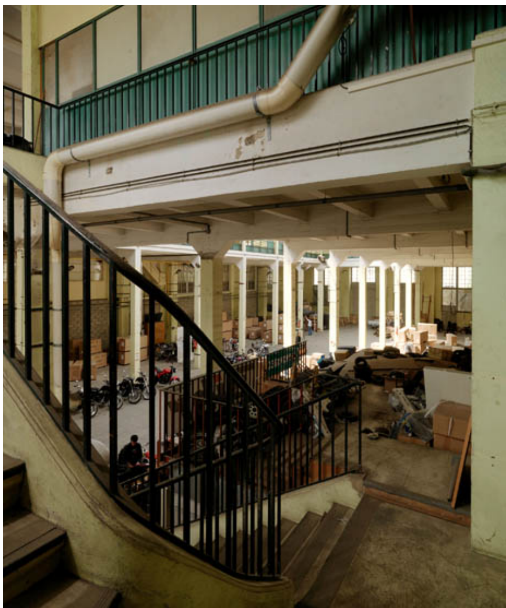
Vue intérieure du magasin général (1915). Structure en béton. Au premier plan, un escalier.
