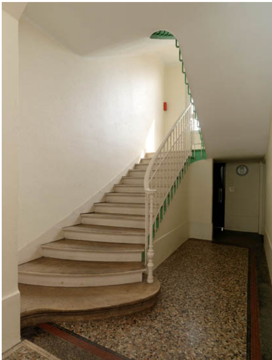
12/14 rue Pasteur. Escalier en chêne ciré, sol recouvert de mosaïque en grès cérame.
