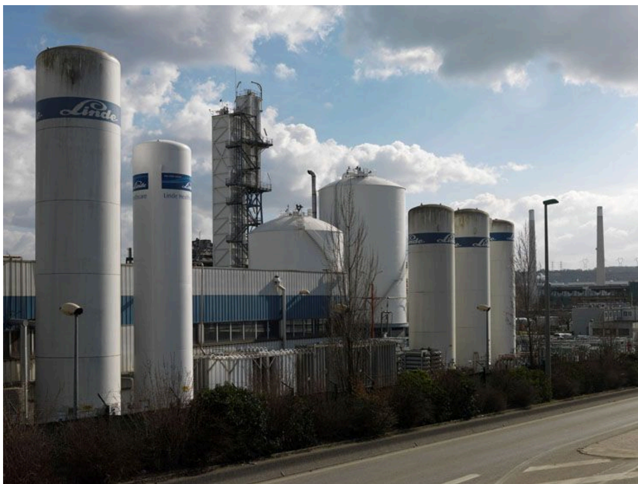
Porcheville, usine de gaz comprimé AGA France. Paysage de zone industrielle : l'usine d'air comprimé AGA France, au sein de la ZI de Porcheville.
