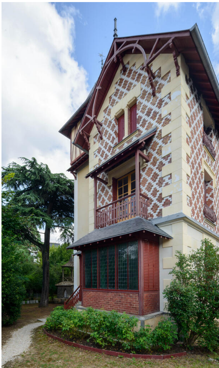
La façade ouest et son bow window.
