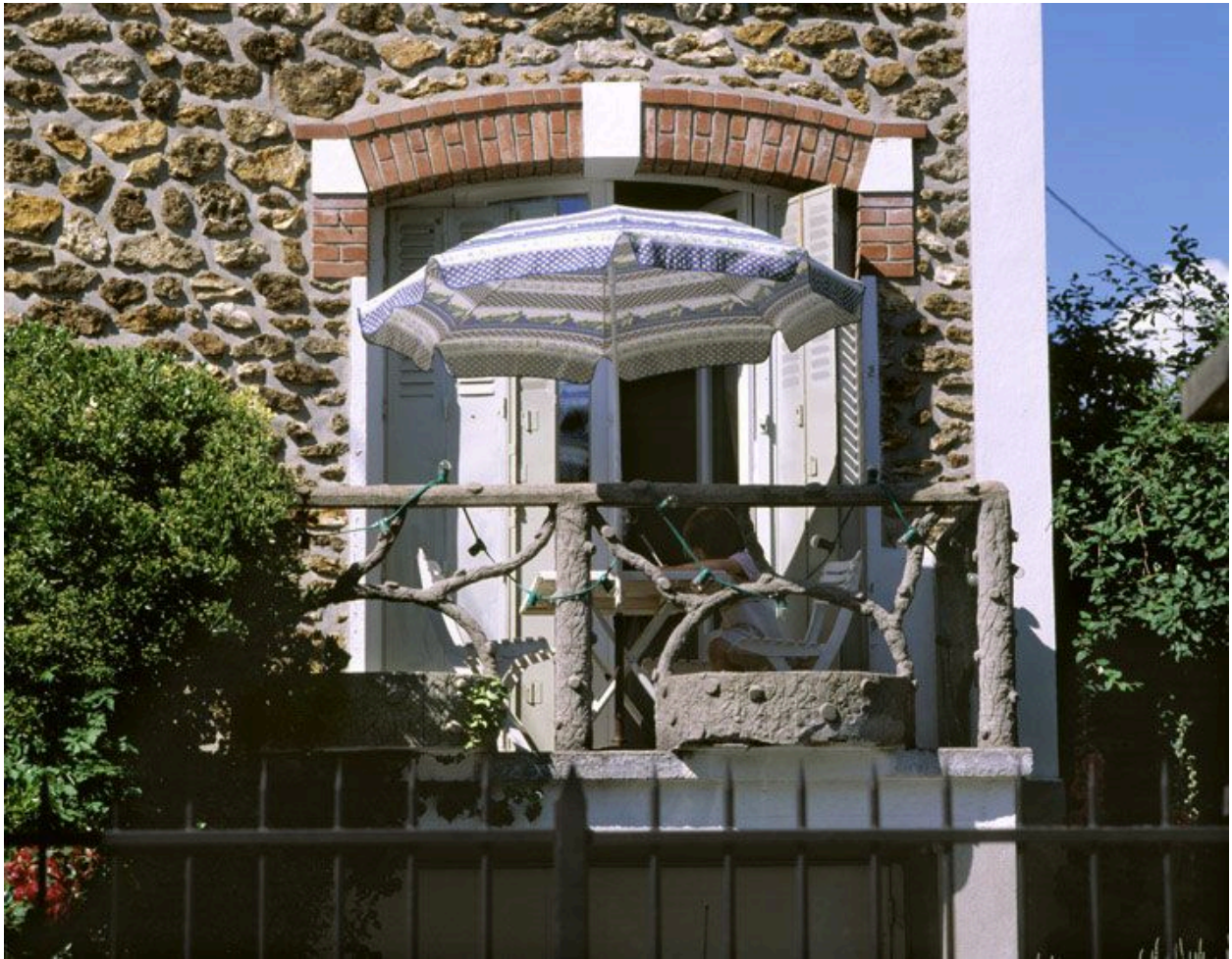
Détail du balcon en ciment imitant le bois d'une maison, 28 rue des Corluis.
