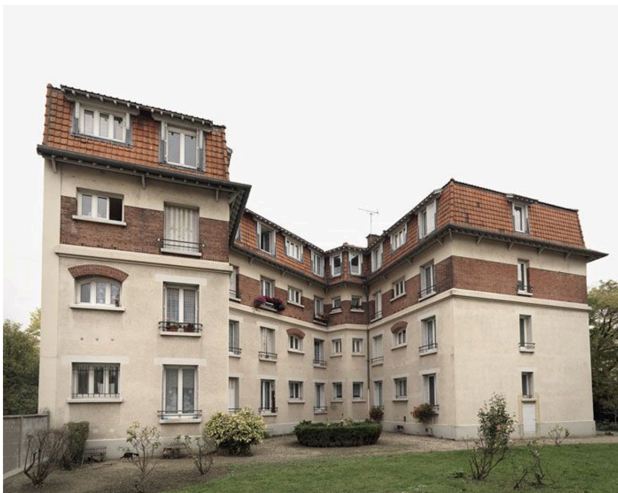
Logements collectifs, rue Vassou.
