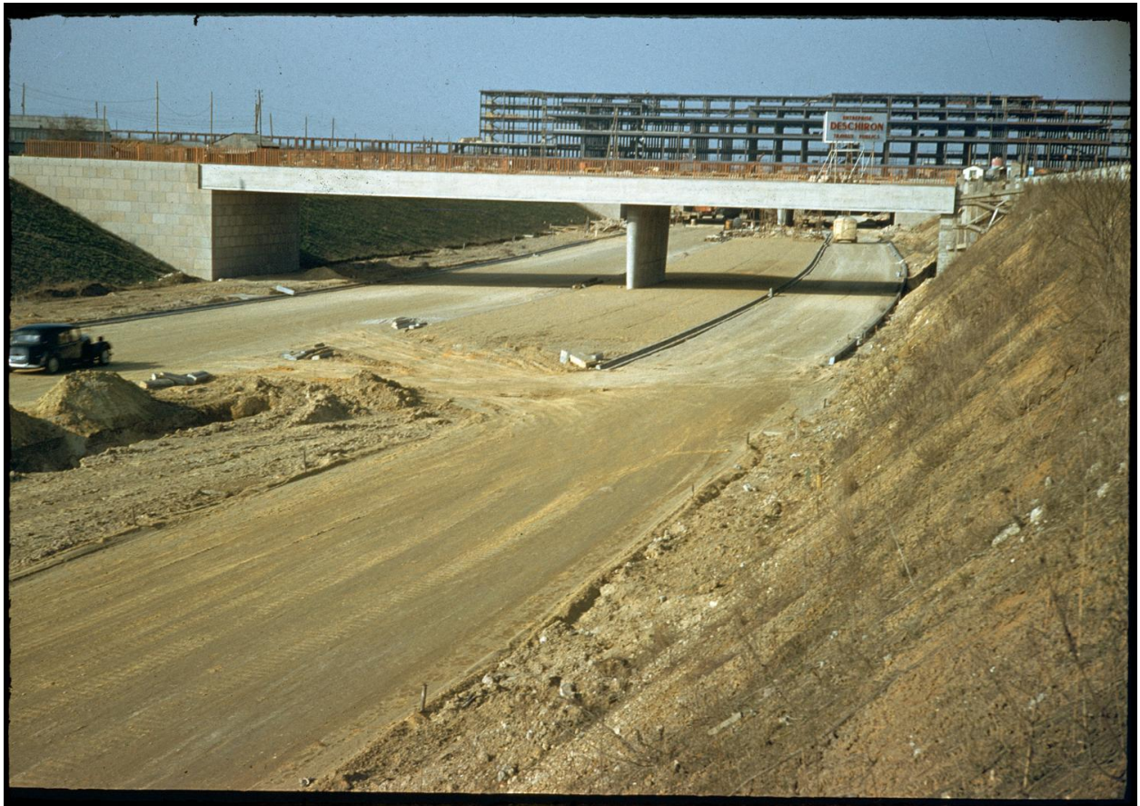
1956 1960 Construction du nouveau tracé de la Nationale 7, vue prise depuis le nord ouest.
