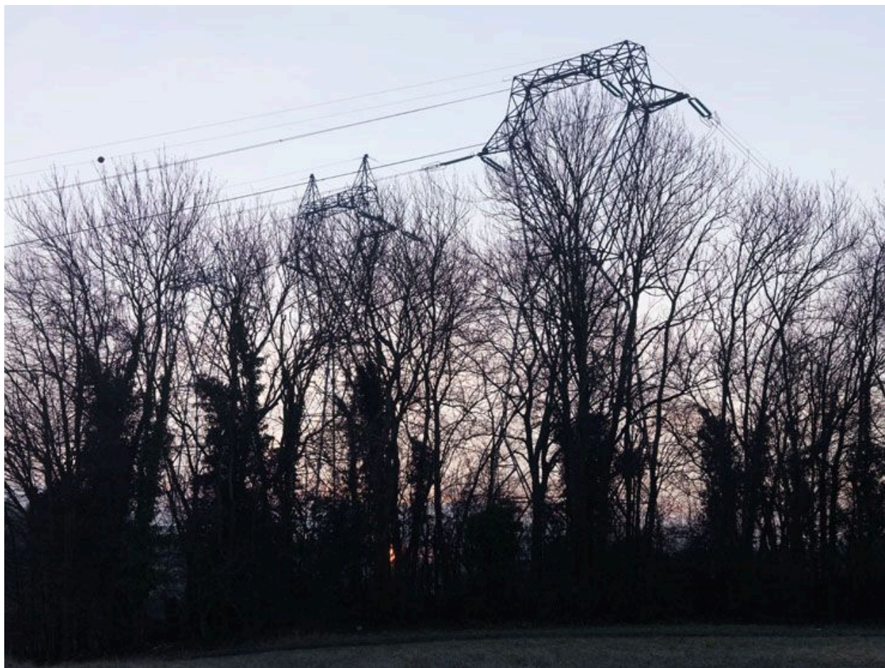
Guerville : pylônes électriques venant de Porcheville entre la Plagne et le golf.
