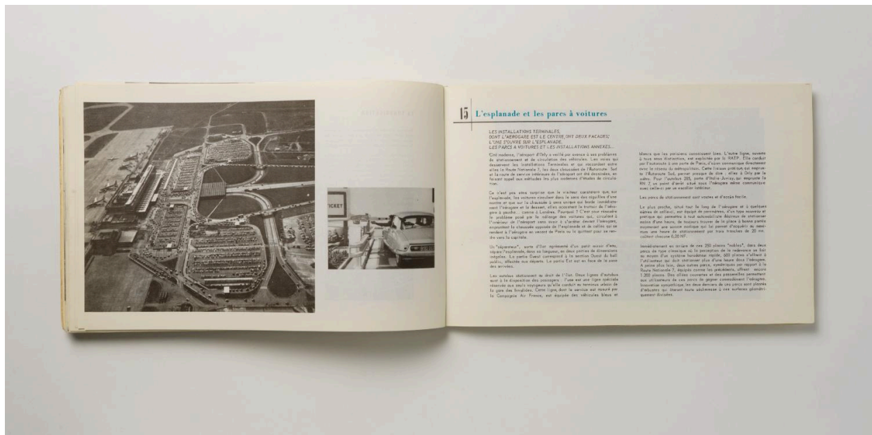
15 L'esplanade et les parcs à voiture, "Installations Terminales Orly", brochure éditée par l'Aéroport de Paris, 1961.
