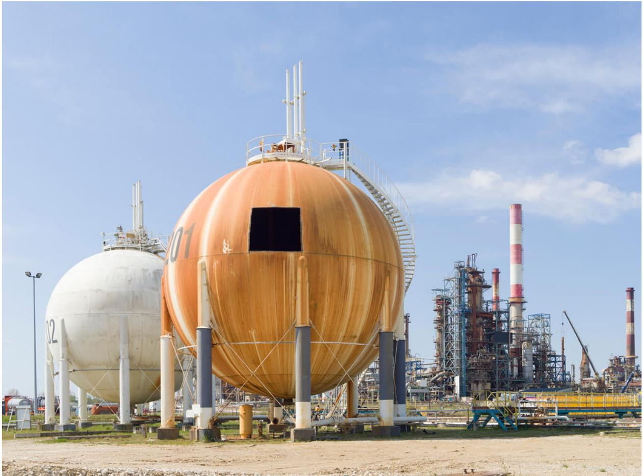
Zone 320, Mouvement de produits. Vue sur la sphère de stockage de gaz D 201 depuis le sommet de la sphère D 202. Une première "fenêtre" a été ouverte au chalumeau, en vue de son démantèlement.
