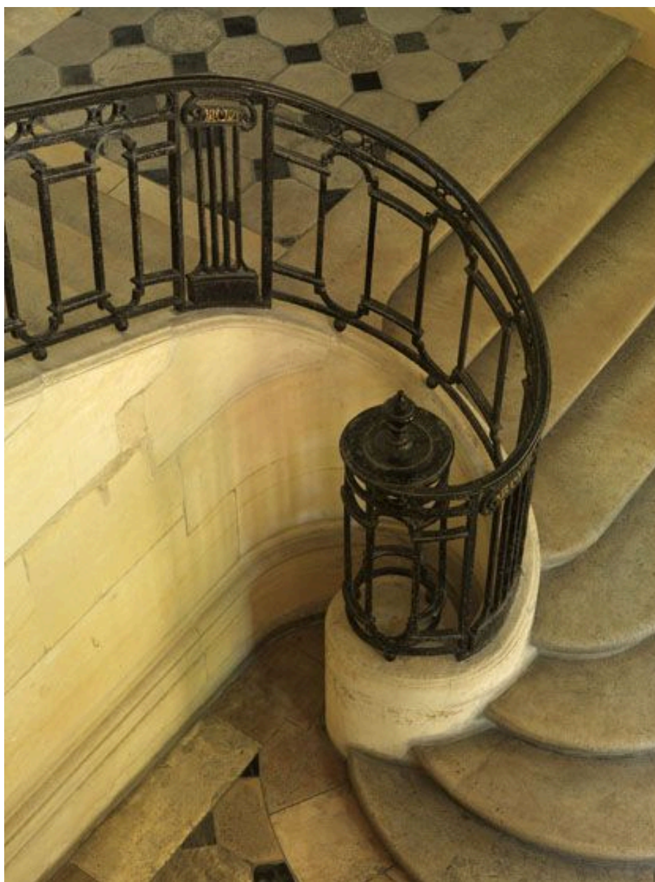
Le départ de la rampe, vue plongeante.
