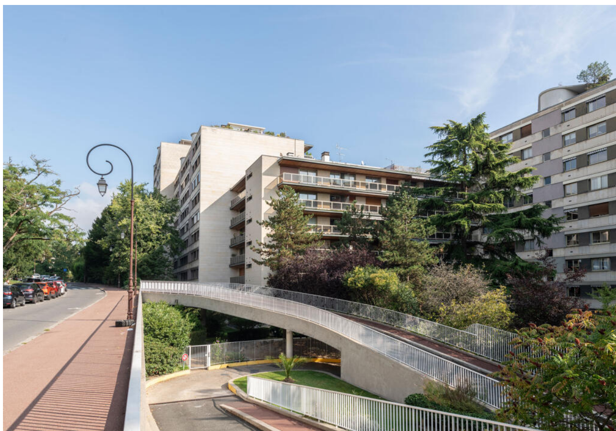
Résidence Parc de Béarn, rampes d'accès au garage souterrain
