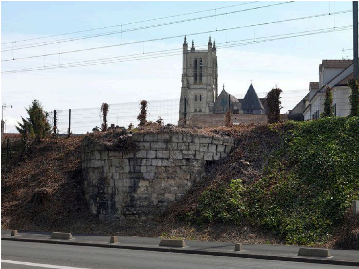
La tour de la Platrière dans le remblai de la voie ferrée, cours Pinteville.
