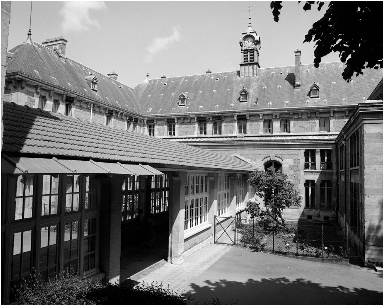
Bâtiment d'administration : la façade arrière (ouest). La galerie couverte menait au jardin d'hiver aujourd'hui disparu. Lycée dit Lycée Lakanal
