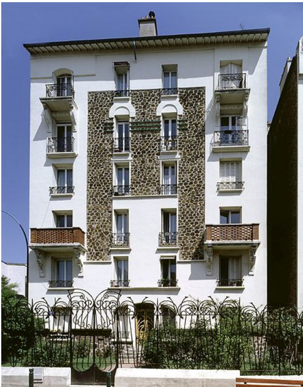
Immeuble, 1 bis rue Bâüyn de Perreuse. Vue d'ensemble de la façade sur rue.
