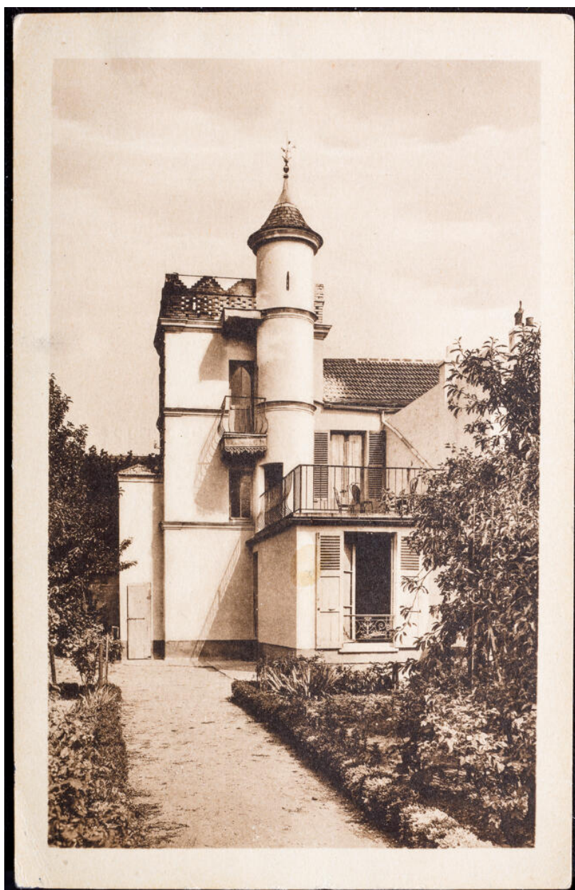
Carte postale ancienne montrant l'arrière de la tour du 24-26 boulevard du Maréchal Foch au cours de la 1ère moitié du 20e siècle (Coll. particulière).
