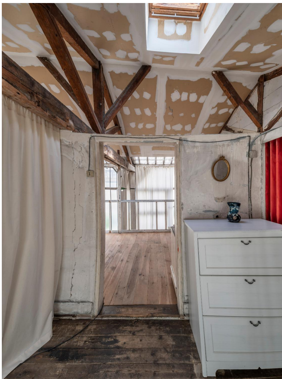
Atelier 11 cité Falguière, demi-étage de comble et mezzanine
