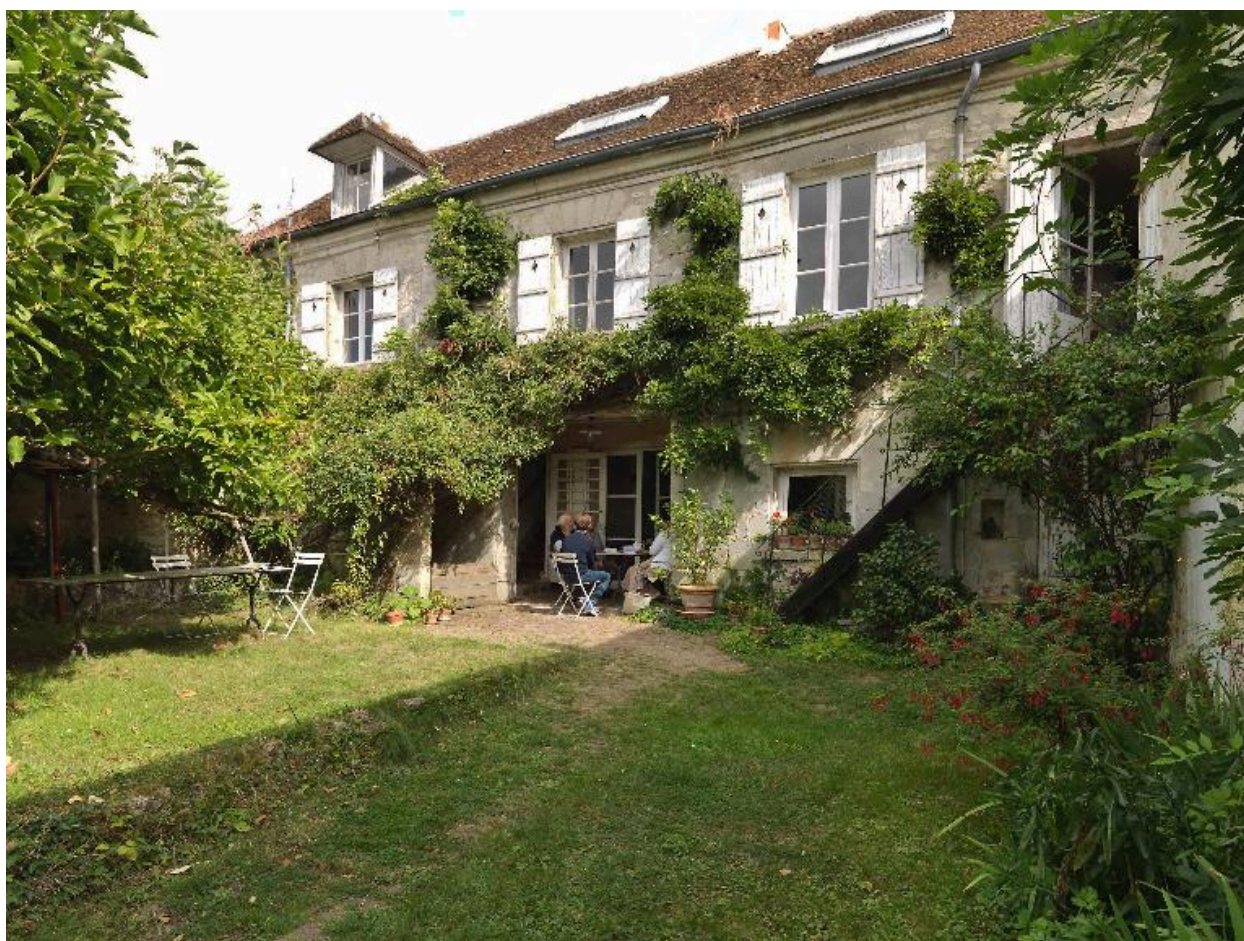
Façade postérieure prise depuis le jardin
