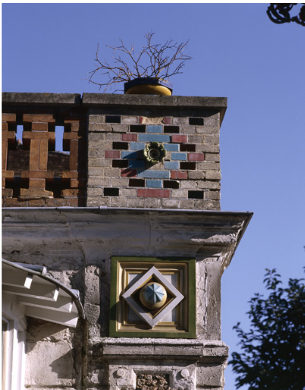
Détail du décor de brique vernissée et de céramique ornant la terrasse accolée à l'aile ouest.
