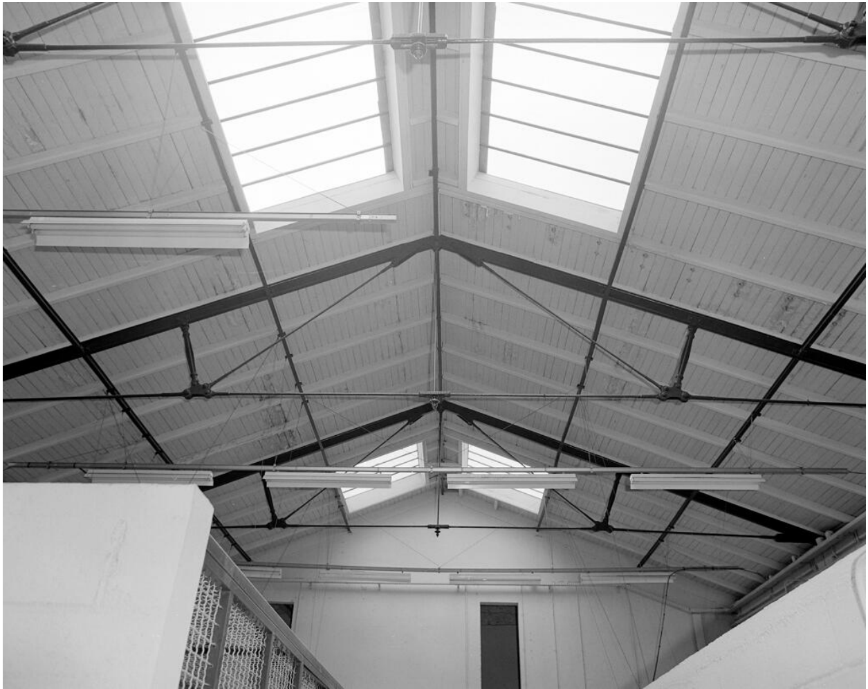
Le manège bâti en 1878: détail de la charpente métallique. Château, Lycée dit Château de le Prevost puis DESCONDE, Lycée du Prince Impérial, actuellement Lycée Michelet
