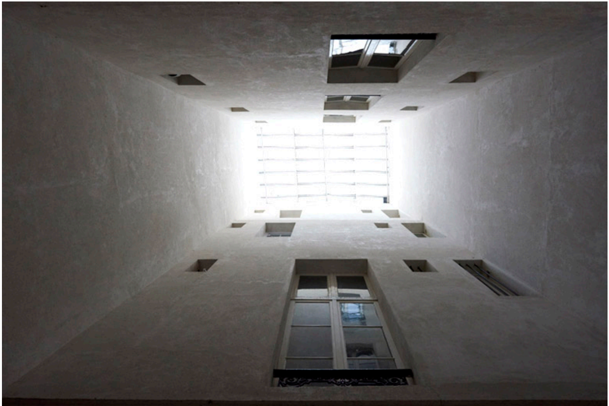
Puits de lumière au centre du bâtiment.
