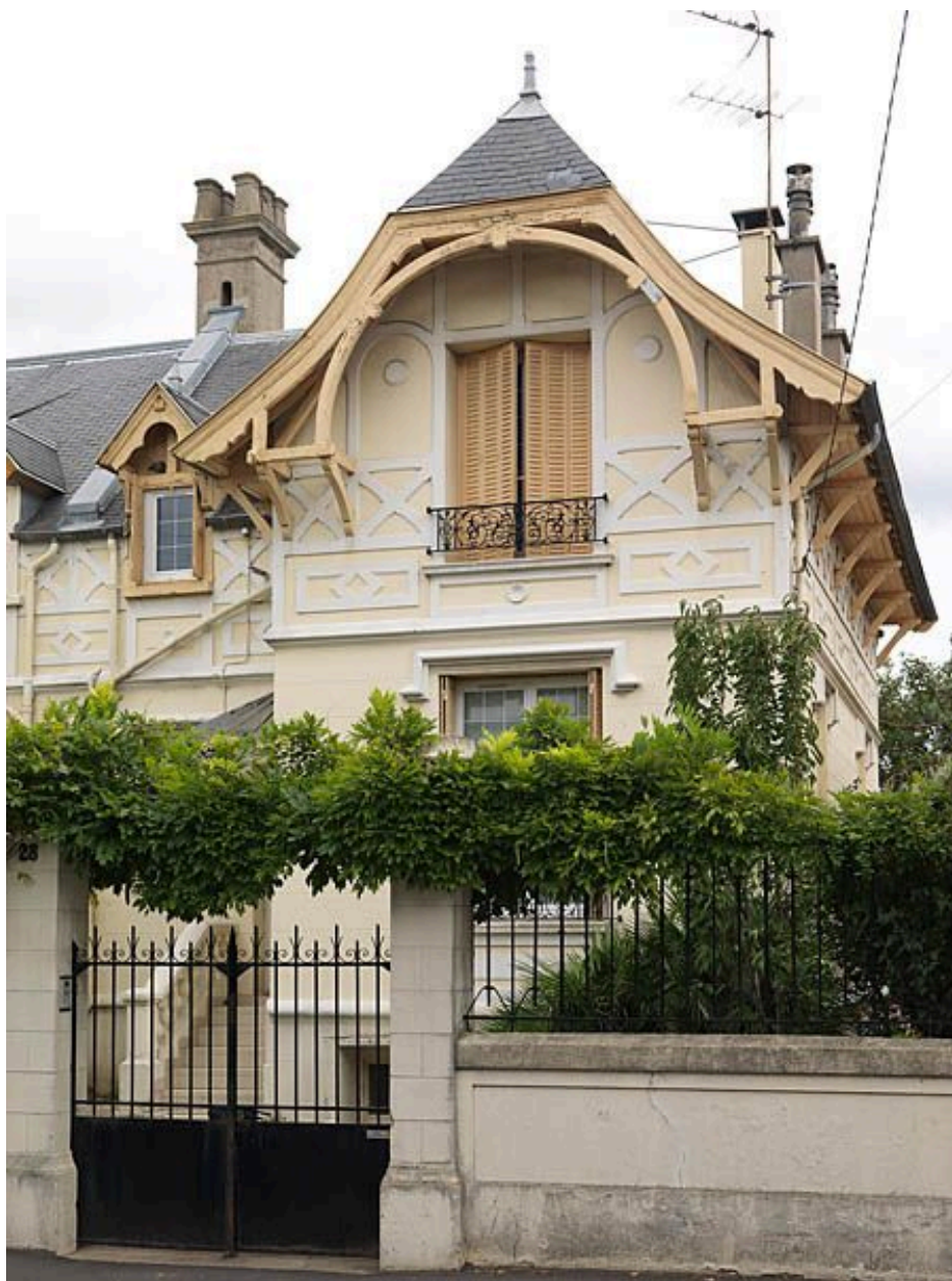
Villeneuve-le-Roi, maison en série (série de 4), 28, 30 avenue Henri Gilbert. Façade sur rue avec pignon.
