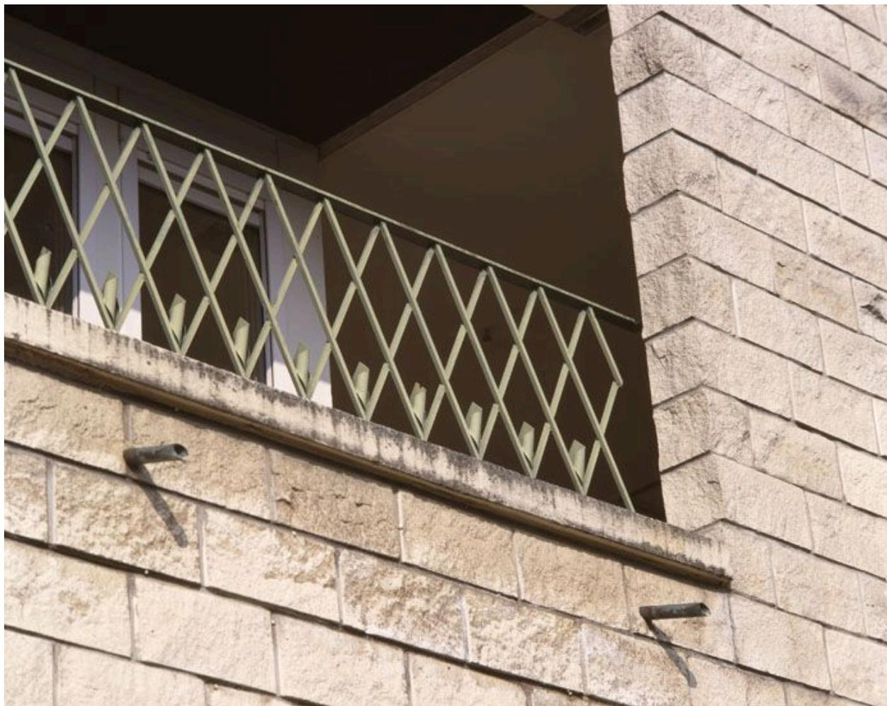
Détail d'une loggia et de son garde corps métallique. On distingue bien la maçonnerie en parpaing de béton.
