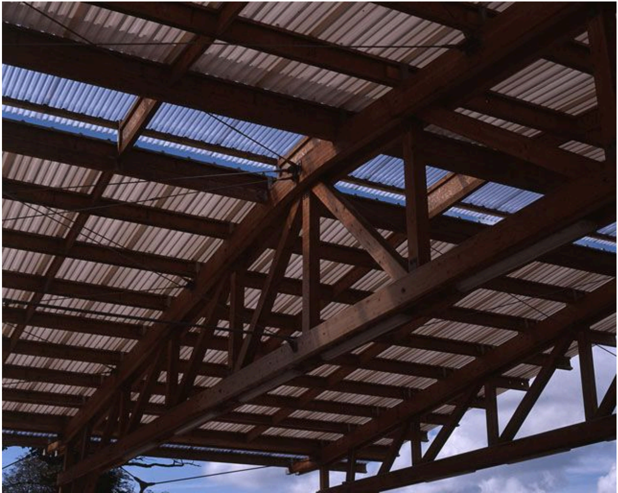
Détail de la charpente du manège (poney-club), près de la rue du Port-aux-Cerises.
