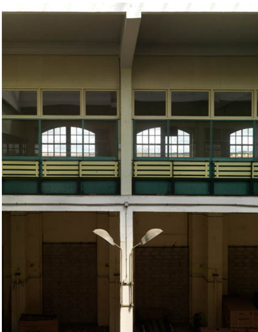
Vue intérieure du magasin général (1915). Structure en béton.
