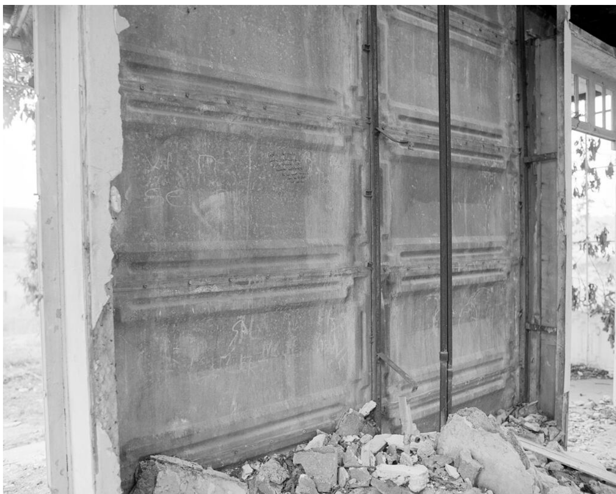
Détail des panneaux métalliques depuis l'intérieur (état en 1991).
