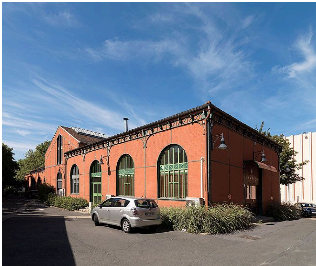
93, Saint-Denis, entrepôt commercial de la Compagnie des Entrepôts et Magasins généraux, 50 avenue Président-Wilson. Vue d'ensemble de cet entrepôt de brique à pan-de-fer.
