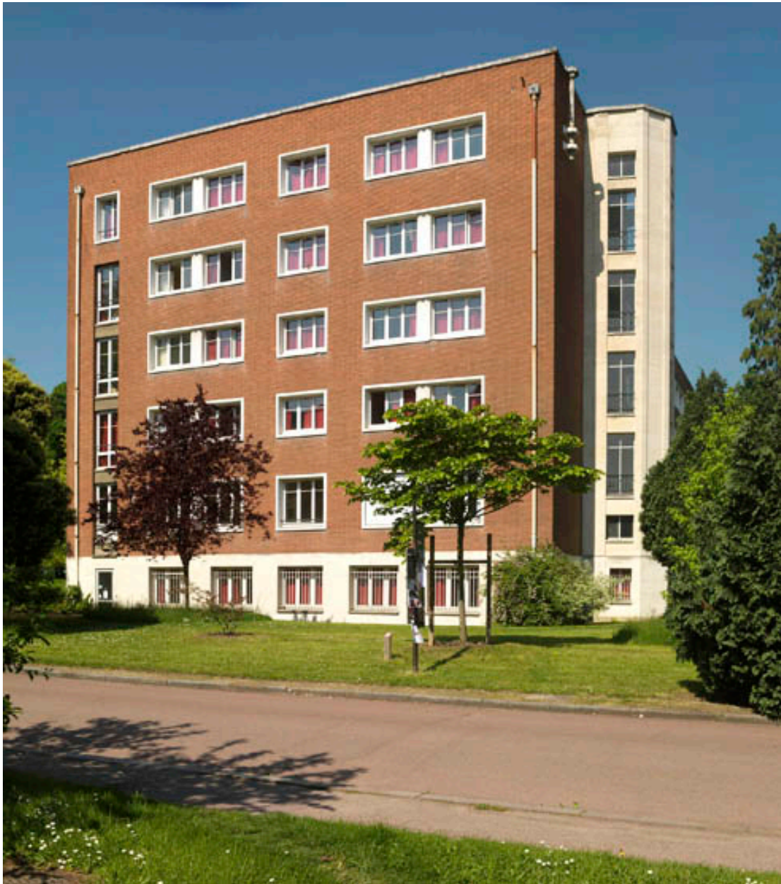
Vue de la façade latérale est.
