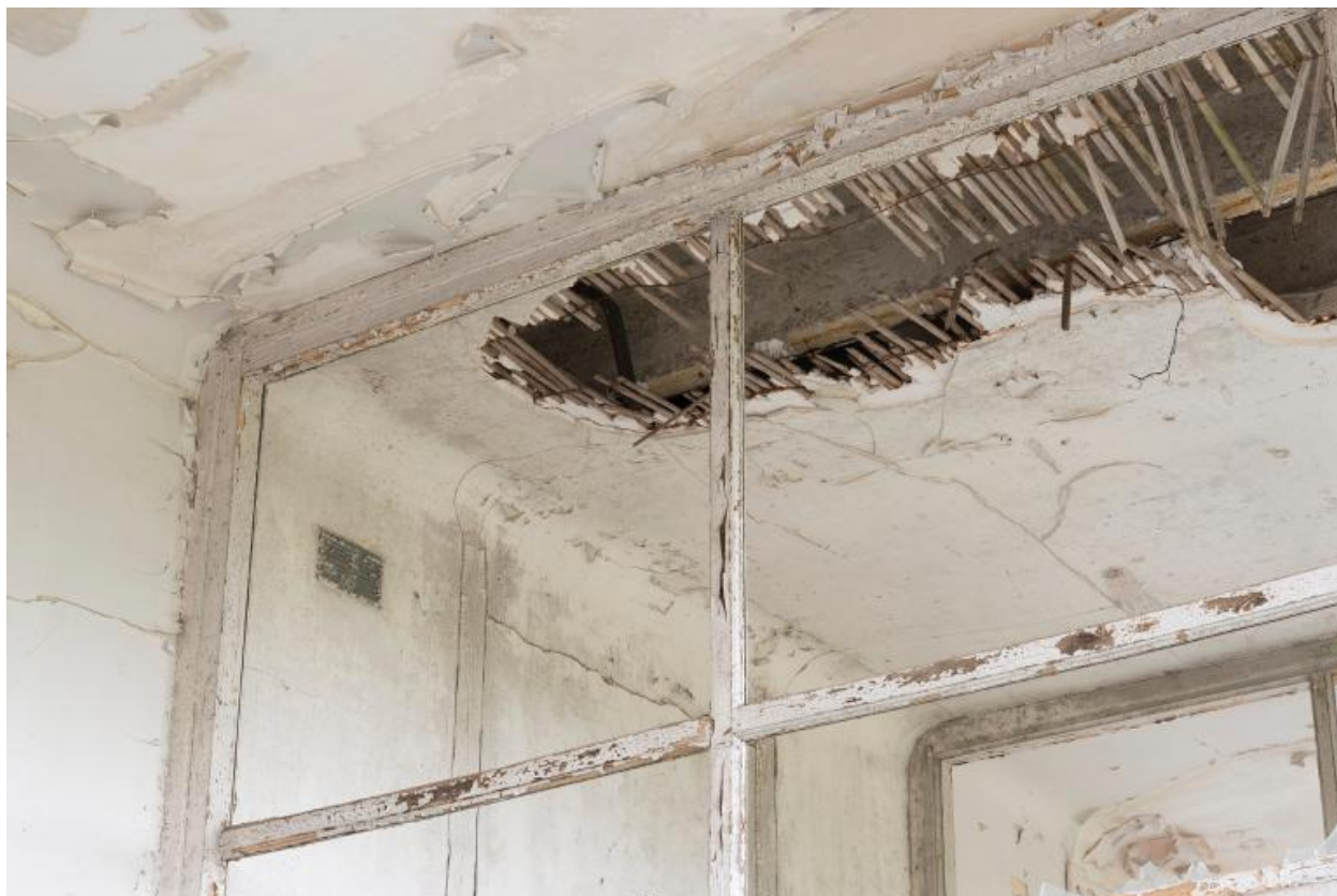
pavillon Bonnefoy-Sibour, détail du latis de chataigner (plafond d'une chambre)
