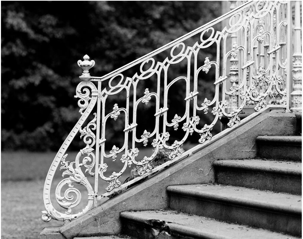
Façade postérieure, escalier de distribution extérieure, détail de la rampe.
