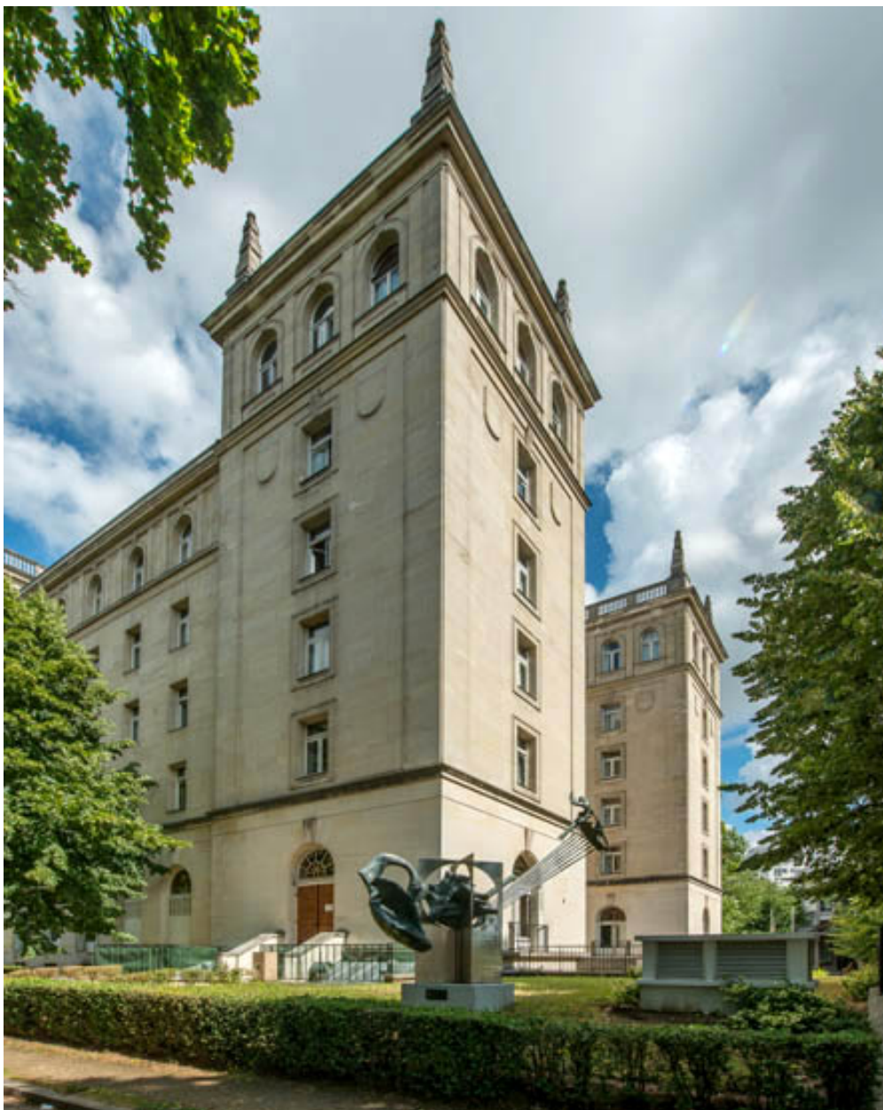
Vue partielle du bâtiment (côté est).
