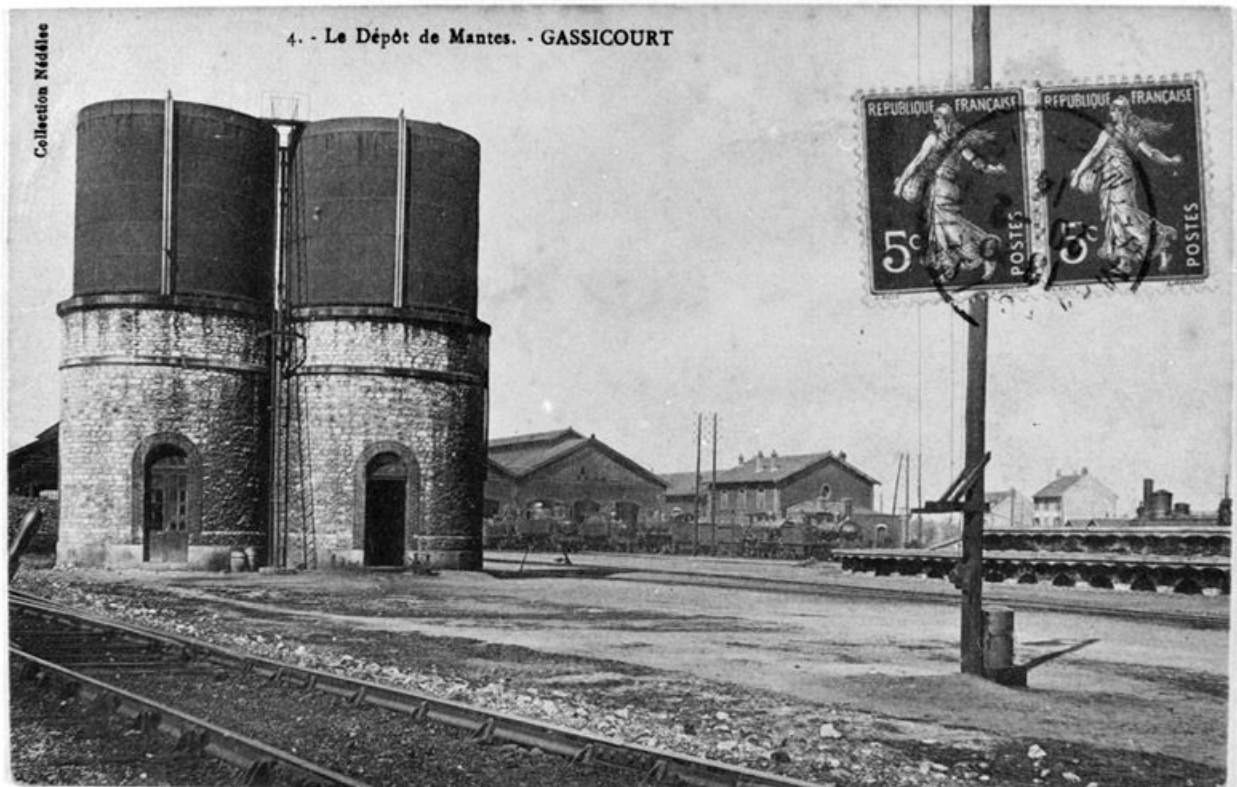
Vue du dépôt de Mantes. On aperçoit au premier plan deux réservoirs et à l'arrière la remise des locomotives, grande halle à charpente métallique. Carte postale (Région Ile-de-France. Fonds CREDOP)
