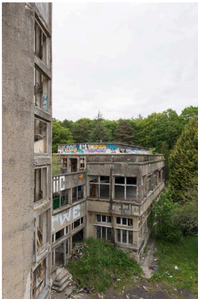
pavillon Bonnefoy-Sibour, vue de la façade sud vers l'est
