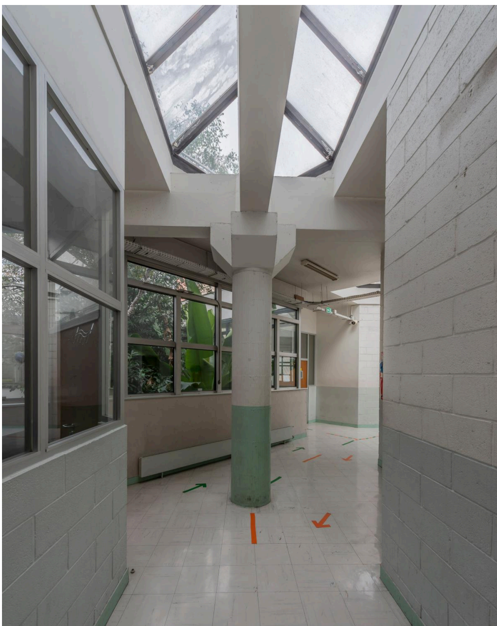
Les couloirs et leur éclairage zénithal. A gauche, un patio végétalisé.
