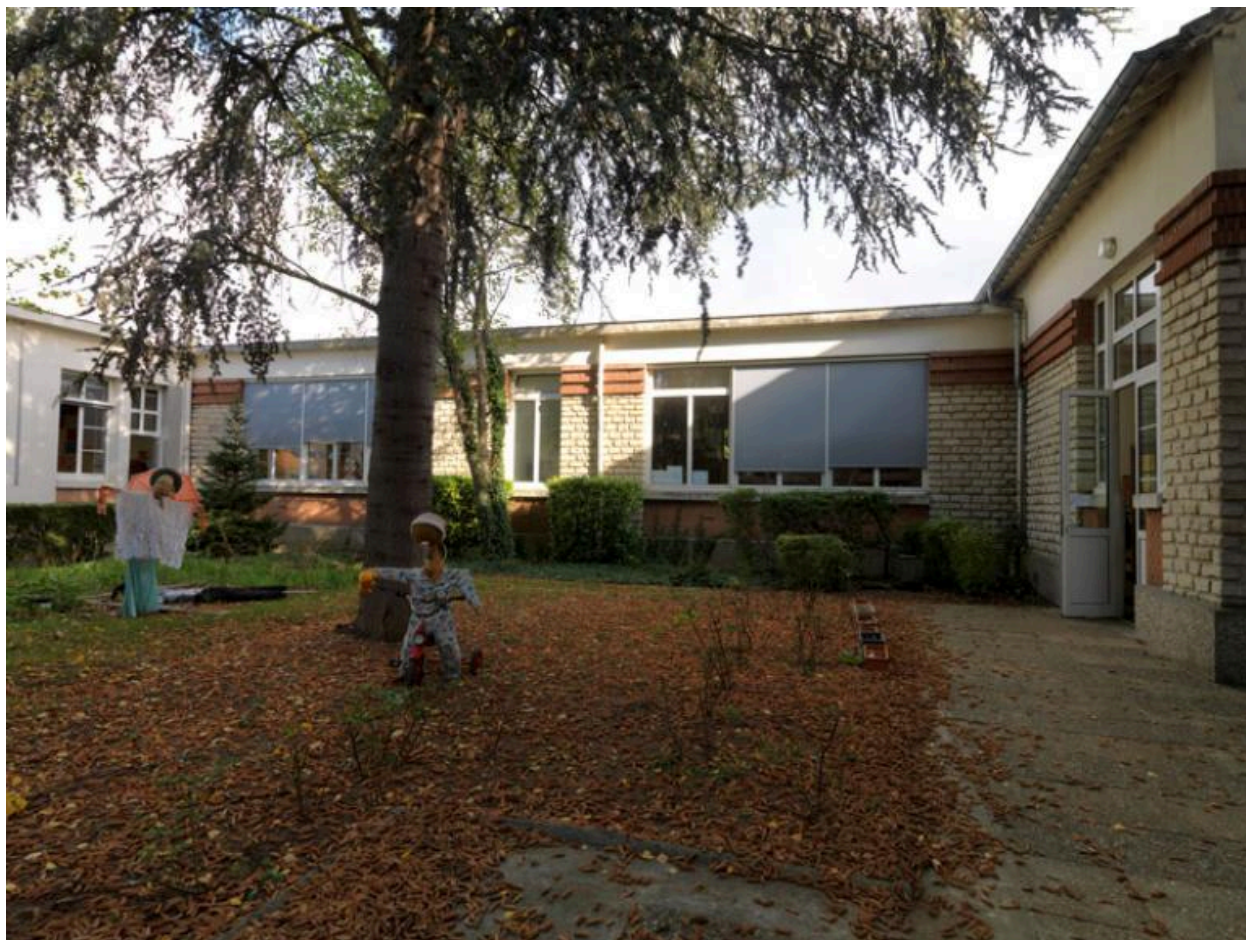
La façade côté cinéma d'une classe de l'école maternelle qui ferme la cour intérieure.
