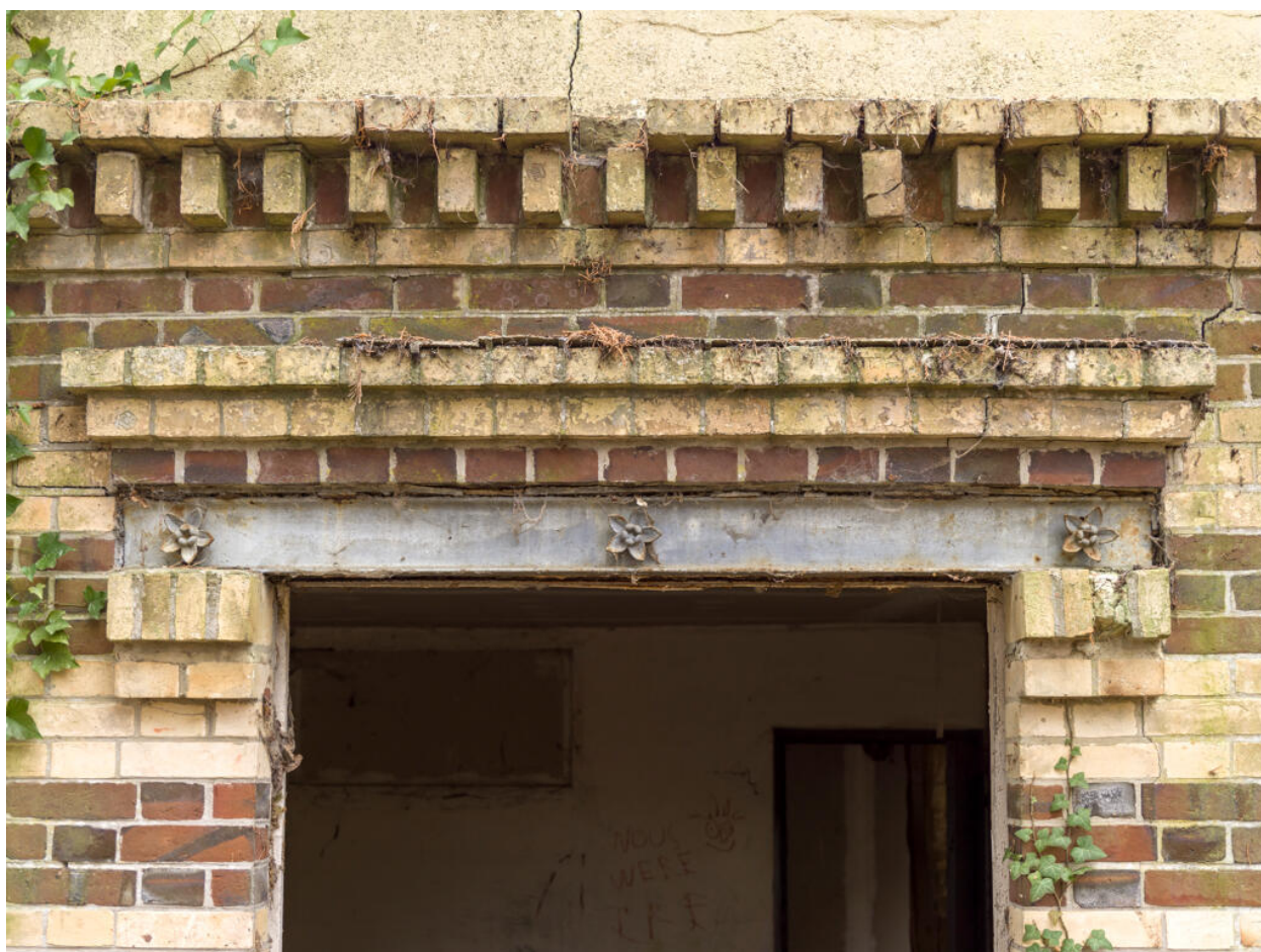
Maison d'Octave Allaire, couverture d'une fenêtre : linteau métallique à fleurons, corniche et denticules en brique.
