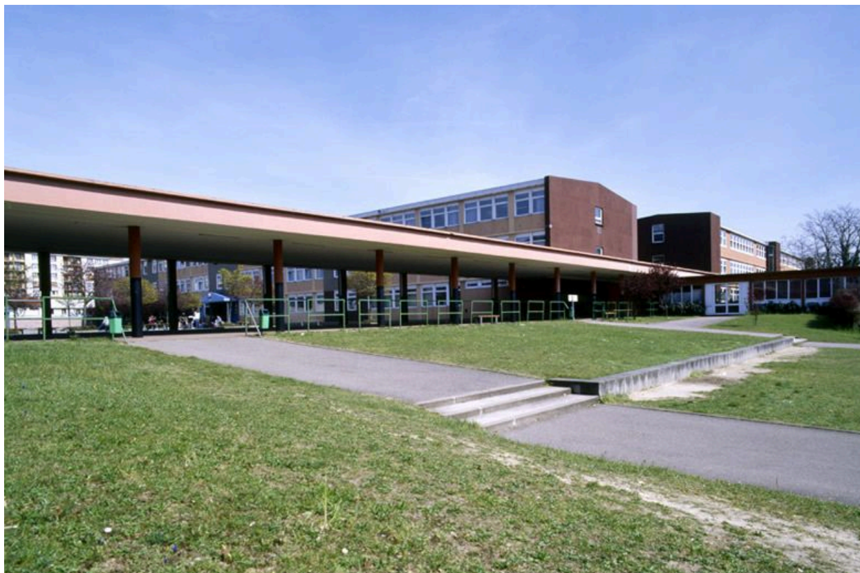
Lycée technique Langevin Wallon, avenue Roger Salengro. Heulot, Julien (architecte communal). Vue d'un des bâtiments et d'une galerie de circulation.
