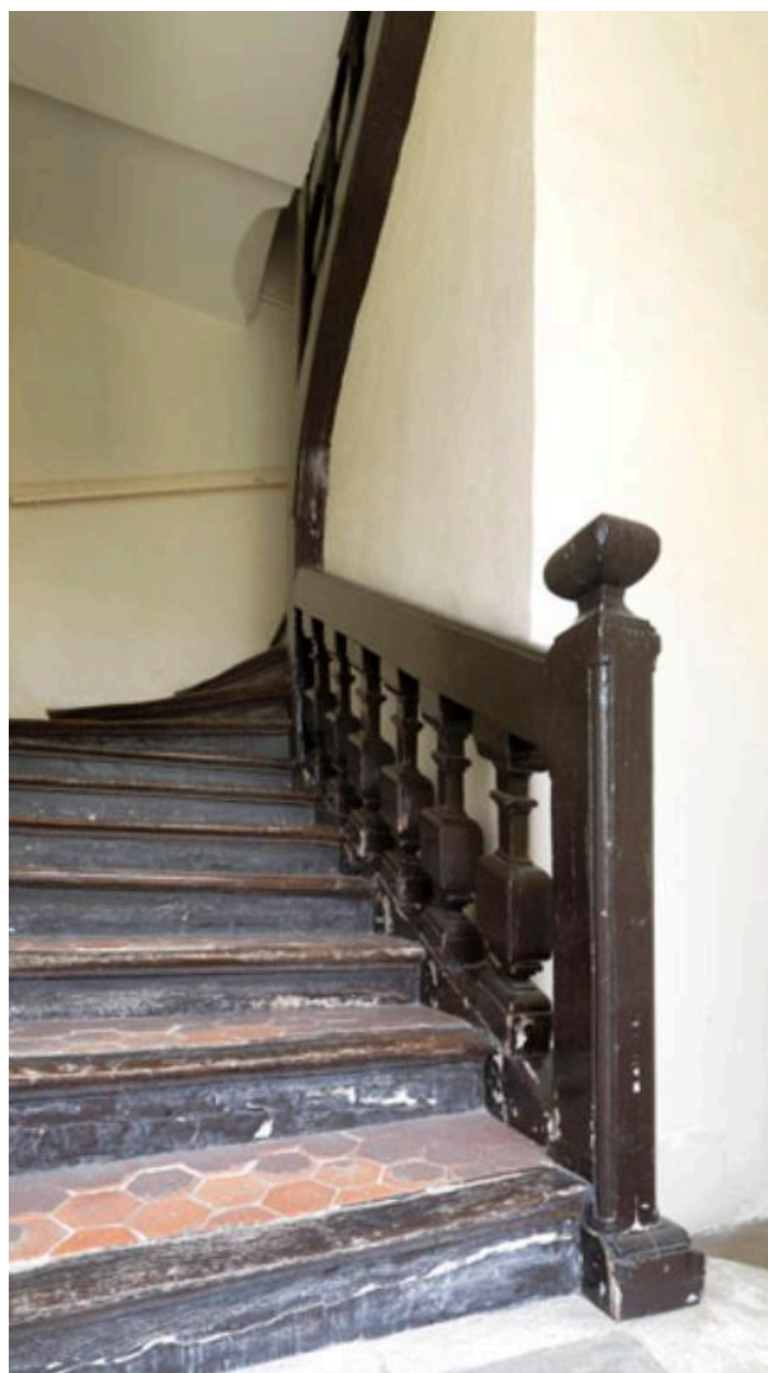
Escalier de service rampe-sur-rampe se trouvant dans l'aile d'entrée.
