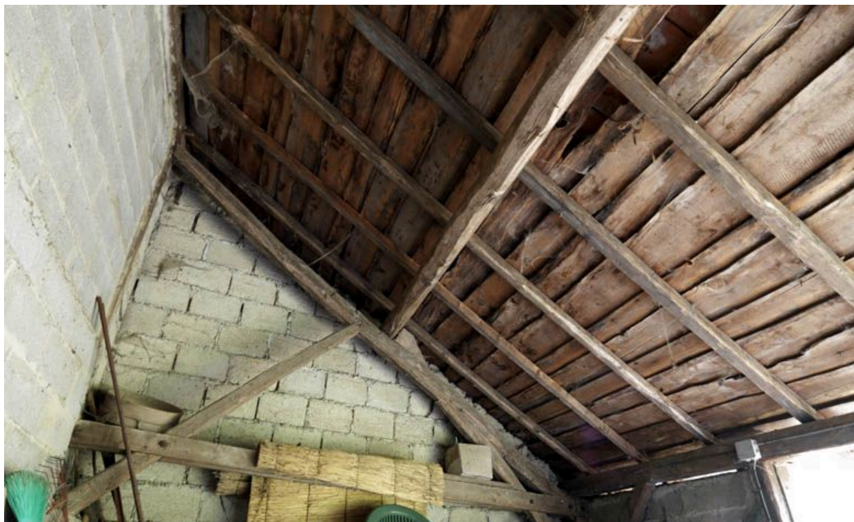
Appentis, détail de la charpente.
