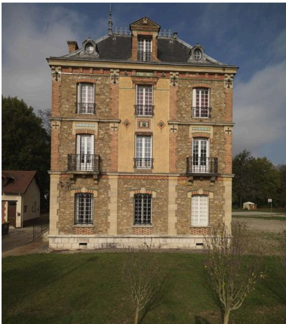
Vue frontale de la façade latérale sud.
