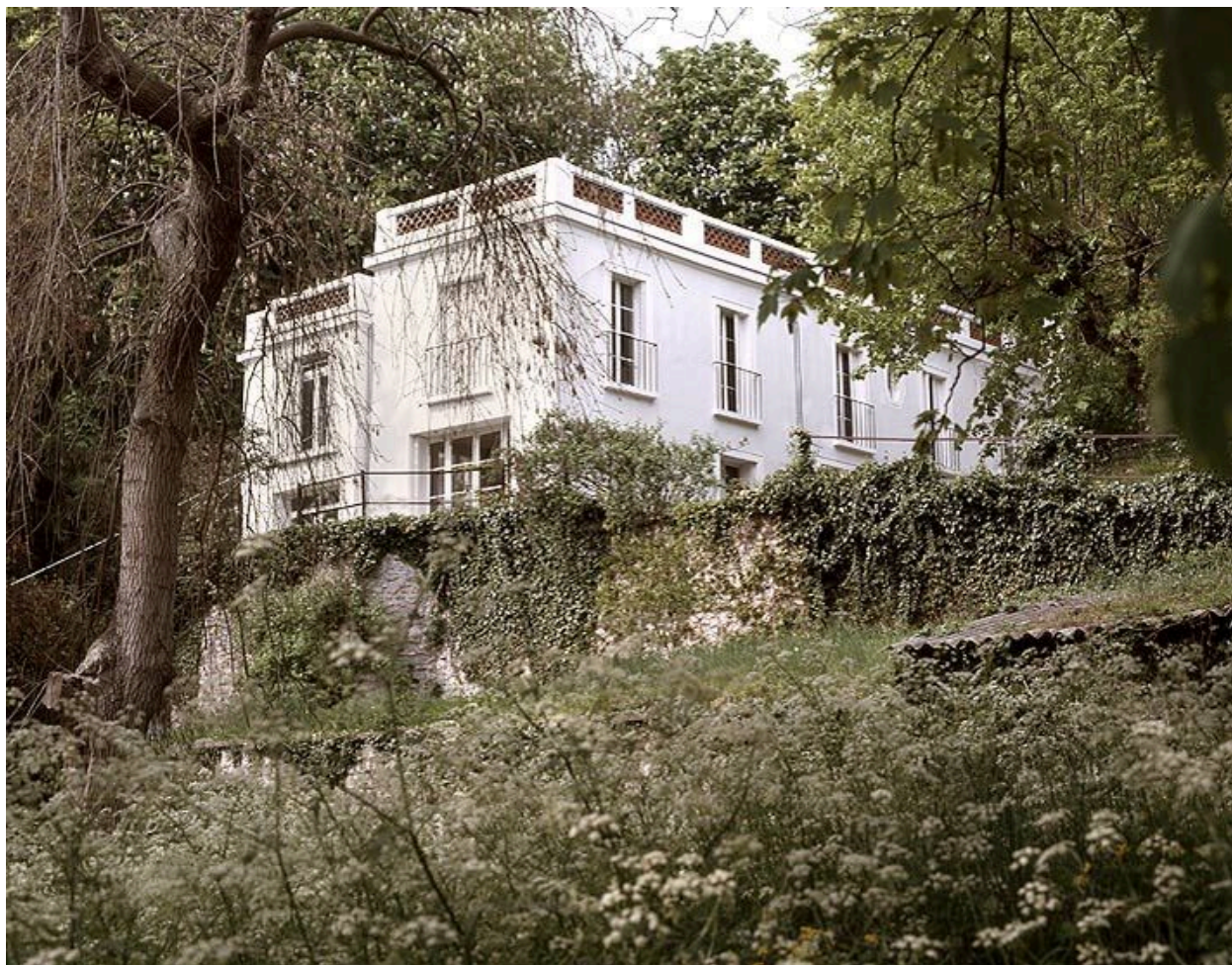
Vue d'ensemble de l'ancienne centrale thermique, 18 quai de l'Ecluse, transformée en maison.
