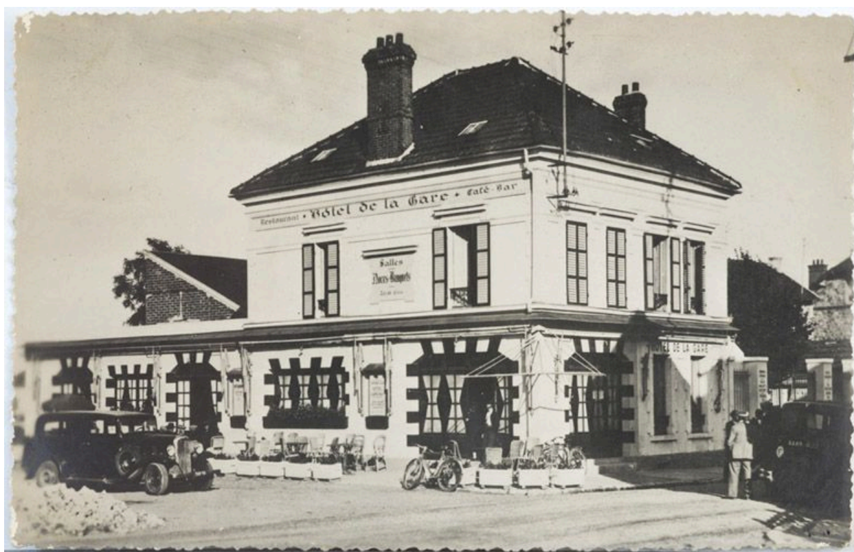
Vue générale de l'hôtel de la gare. Carte postale, vers 1929. (Collection particulière).
