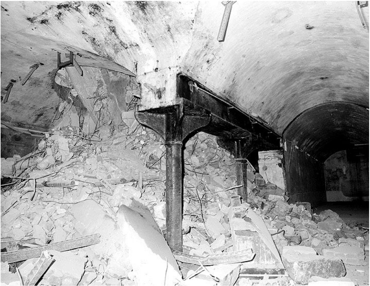
Atelier de réparation : détail de la structure métallique. Photographie avant destruction, 1989. (Ministère de la culture, Inventaire général. 89SG709X)
