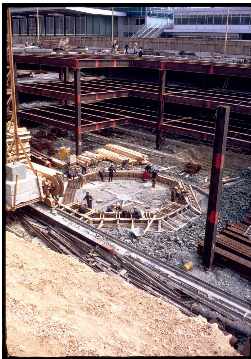
28/04/1968, construction du parking souterrain P1.
